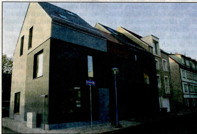
Energieeffizientes Bauen geht auch in der Innenstadt, so wie bei dem Doppelhausneubau an der Stelle des alten Brauhofes in der Schwabhäuser Straße. Foto: Heiko Stasjulevics
